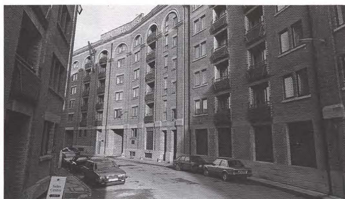
Rehabilitación de los almacenes Gun Wharves, Wapping.
